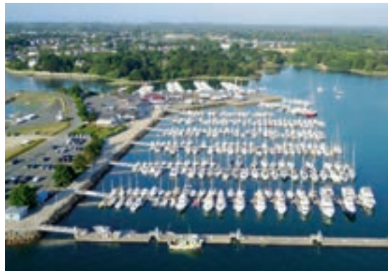
L'attractivité de notre port de plaisance passe par le renouvellement et la modernisation de ses infrastructures
