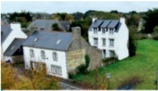
L'implantation de la Maison Médicale dans le bourg sera menée à terme
