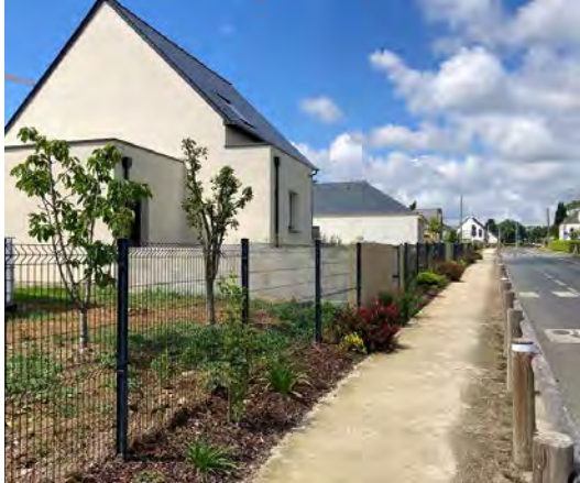
Exemples de grillage doublé de végétation
